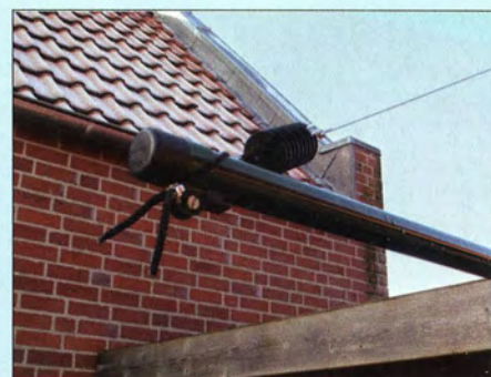
Bild 6: Mit einem horizontalen Ausleger wird der Carport quasi verlängert.
