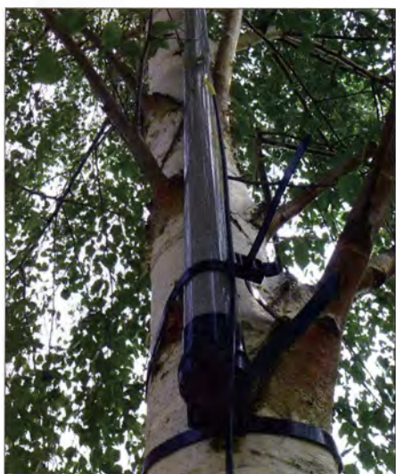
Bild 1: Untere Befestigung des Teleskopmastes; das obere Ende hält in der Baumkrone von selbst.
