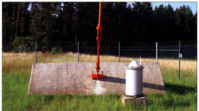
Bild 3: Eines der drei Abspannfundamente der obersten Pardunen; der zylinderförmige Körper rechts enthält die Drossel zur Erdung des Abspannseils.
