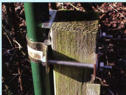
Bild 5: Befestigung des Zaunpfostens an einem Vierkantholz des Gartenzauns
