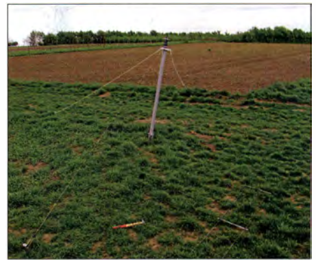
Bild 15: Schräg stehender Mast in zwei ge- spannten Leinen
