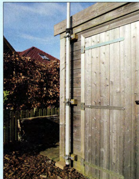
Bild 2: Halterung des FTM am Geräteschuppen des Carports Fotos: DF2BC
