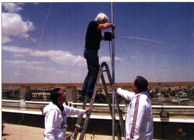
Franz, DJ9ZB, bei der Endmontage der Cushcraft R7-Vertikalantenne unter den Blicken von VR2KF und RA9USU
