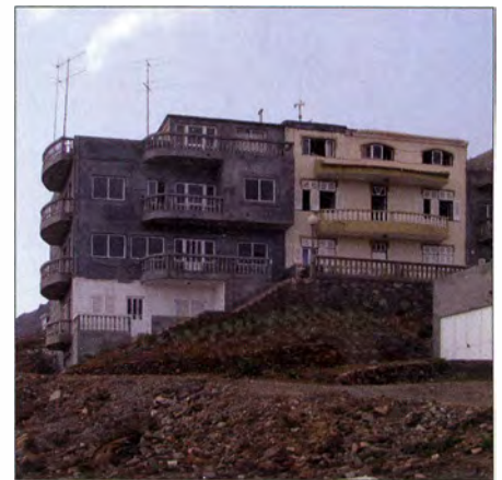
Hoch oben auf dem Berg das Funk-QTH von D44TS (OP DL3GCS): Gefunkt wurde im Rohbau, gewohnt nebenan in einer netten Pension.
